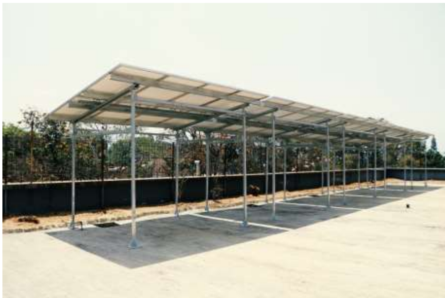
Solar PV Rooftop di Labtek IV – FTTM ITB (sumber: fttm.itb.ac.id )
