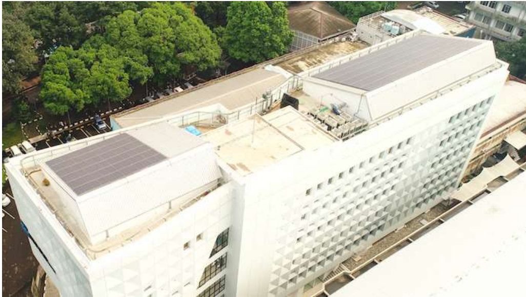
Solar PV Rooftop di Labtek XIV – SBMITB
